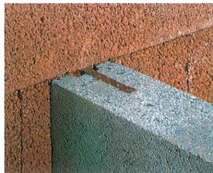
Anbindung durch Stumpfstoß-Technik
